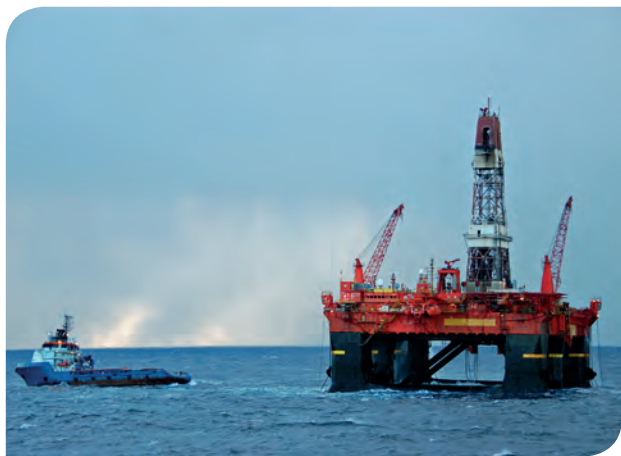
Severné more- ropná veža
